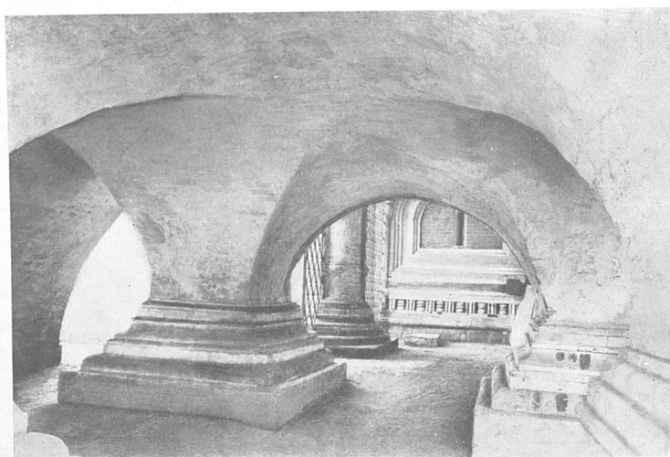
ОТКРЫТЫЕ СТОЛБЫ ПЕРЕХОДОВ ПОД СЕВЕРНЫМ КРЫЛЬЦОМ. УСТОИ, ПОДДЕРЖИВАЮЩИЕ ЛЕСТНИЦУ СЕВЕРНОГО КРЫЛЬЦА. Снимок с юга на север
