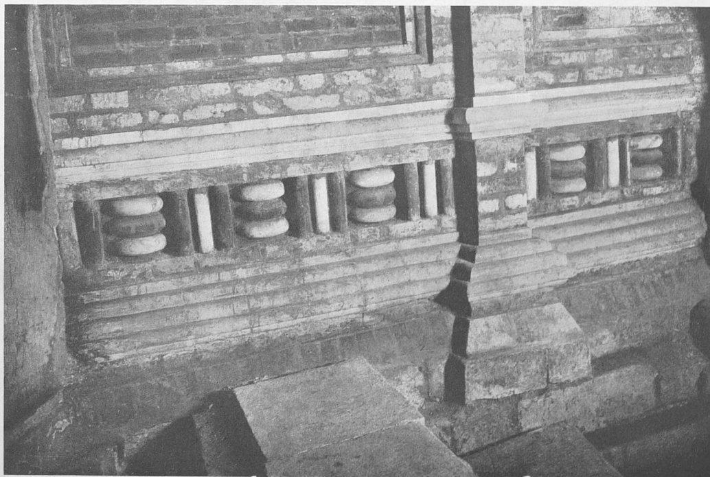
1. РЕСТАВРАЦИОННЫЕ РАБОТЫ АРХ. Д. П. СУХОВА ПО ВЫЯВЛЕНИЮ ПРОФИЛЯ КОЛОННЫ У СЕВЕРНОГО СТОЛПА СОВОРА. 1924. 2. ЦОКОЛЬ XVI в. У ЗАПАДНОЙ СТЕНЫ СОВОРА (открытый Д. П. Суховым) ПОСЛЕ РЕСТАВРАЦИОННЫХ РАБОТ. 1924.
