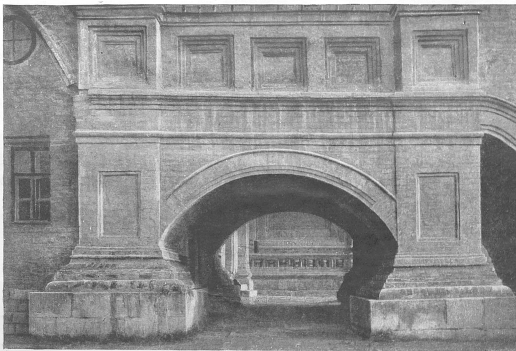
1. НАЧАЛО РЕСТАВРАЦИОННЫХ РАБОТ В 1921 г. ОТКРЫТИЕ АРОК СЕВЕРНОГО КРЫЛЬЦА. 2. ВИД ОТКРЫТЫХ АРОК СЕВЕРНОГО КРЫЛЬЦА СОБОРА ПОСЛЕ ОКОНЧАНИЯ РЕСТАВРАЦИОННЫХ РАБОТ. 1924. 3. ОПОРНЫЕ СТОЛБЫ И СВОДЫ СЕВЕРНОГО КРЫЛЬЦА. В глубине видна стена северного столпа.
